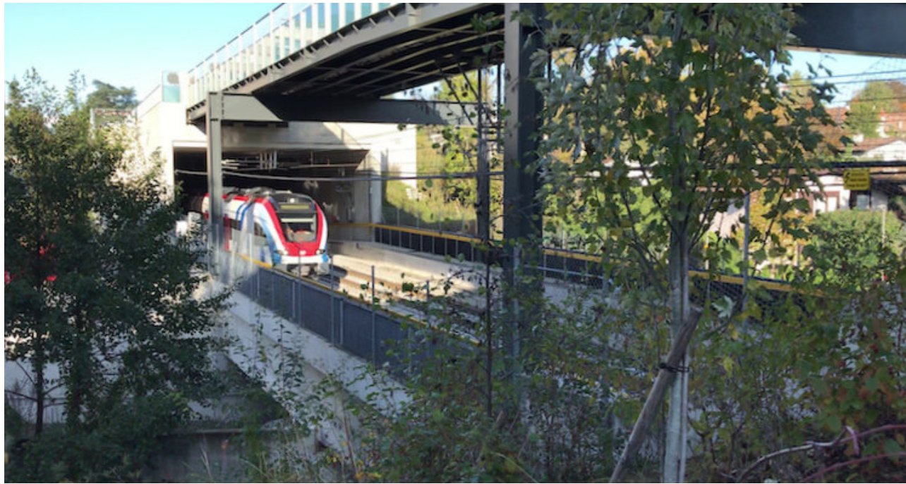
Vue du pont « ouvert », traversant la Seymaz
